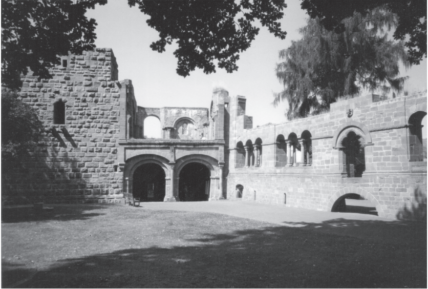
Innenhof der Kaiserpfalz Gelnhausen
